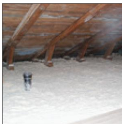
Efter tilläggsisolering med träfiber. Klart!
