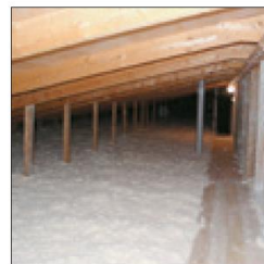
Efter tilläggsisolering med träfiber. Klart!
