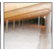
Efter tilläggsisolering med träfiber. Klart!
