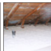
Efter tilläggsisolering med träfiber. Klart!
